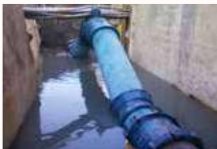
← Remplacement d'une conduite percée
