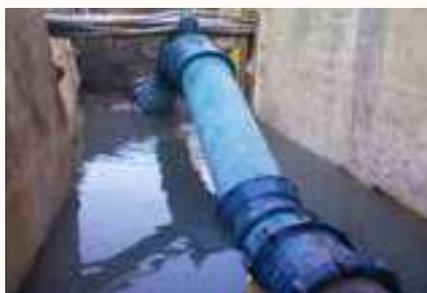
← Remplacement d'une conduite percée
