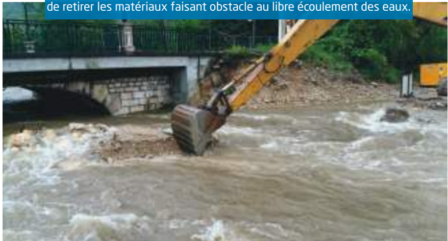
La montée du niveau du Furon a nécessité l'intervention d'engins afin de retirer les matériaux faisant obstacle au libre écoulement des eaux.
