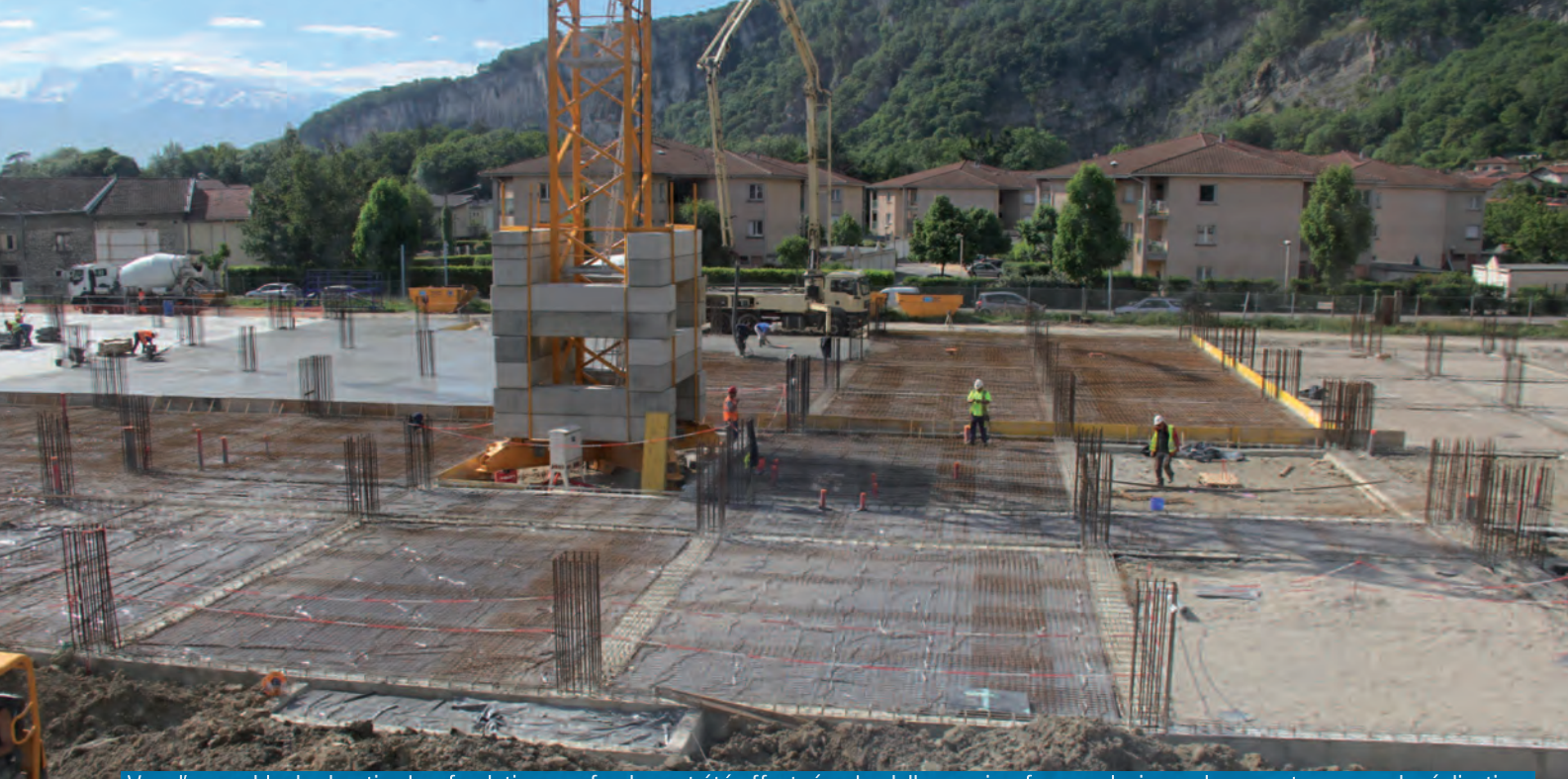
Vue d'ensemble du chantier. Les fondations profondes ont été effectuées. Le dallage qui se fera en plusieurs phases est en cours de réalisation
